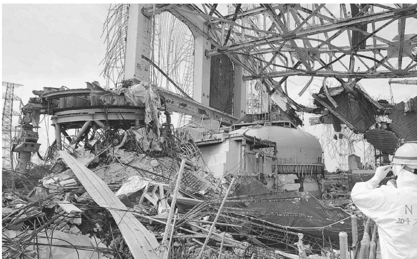
水素爆発によって崩壊した建屋上部の残骸が散乱する東京電力福島第1原発4号機の5階スレッシュヨンプラ。7月11日までには撤去されました。5月26日、福島県大熊町
